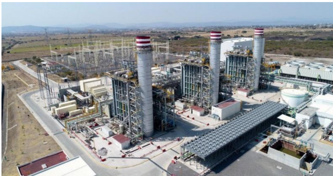
Figura. 2. Central Termoeléctrica de Huexca, Morelos.
